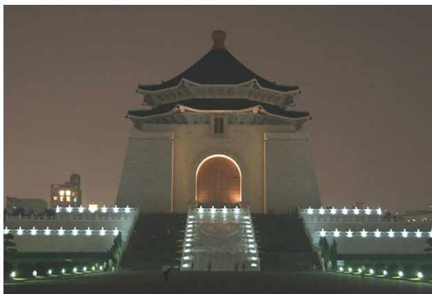
台北中正紀念堂堂體照明High Power LED
